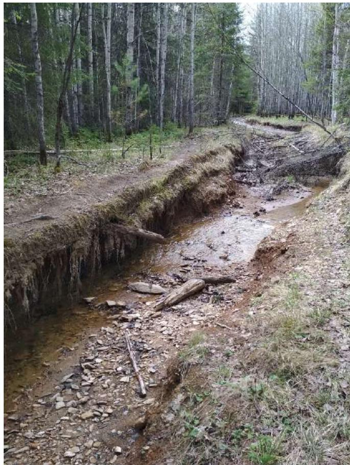
Рис. 2. Промоина на месте лесовозной дороги в нижней части восточного склона горы Шунут (фото авторов)
