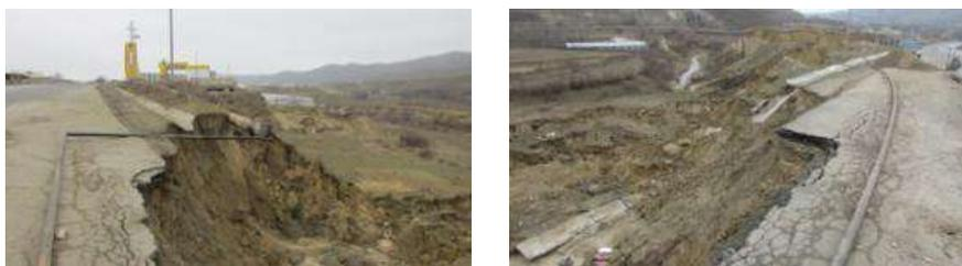
Рис. 3. Деформация полотна автодороги Махачкала — Леваша в результате активизации оползневых процессов
